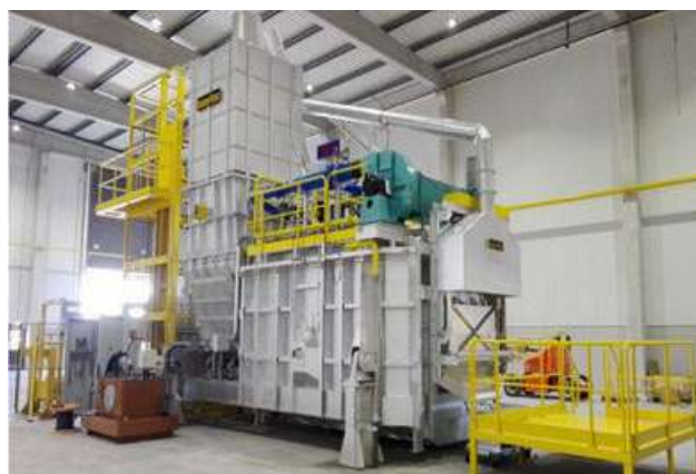
Forno Torre de Fusão
